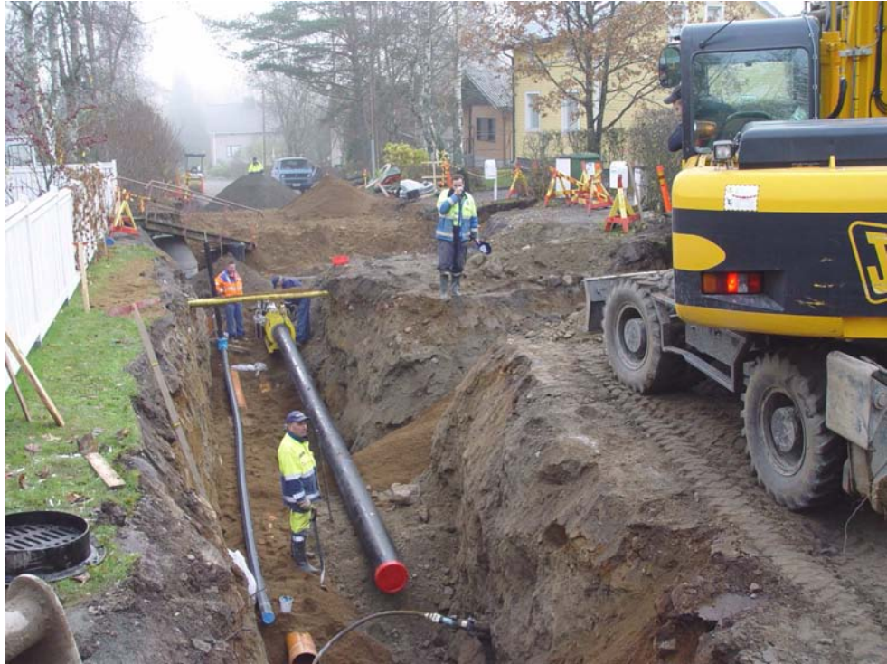
KUVA 2 Hämeenlinnan Papinniityn alueelta Heimontieltä vesihuollon ja kadun saneeraus vuonna 2004.
