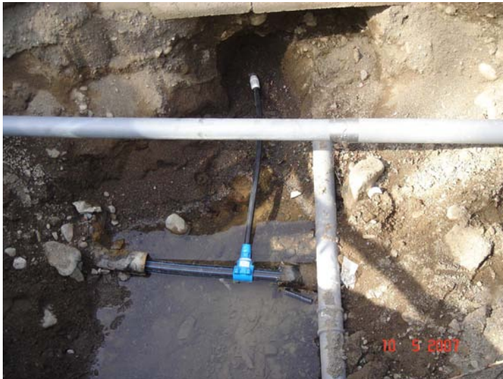
KUVA 6 Erottajakadun saneeraustyömaalta tonttijohdon poiminta sujutustekniikalla uusittuun vesijohtoon
