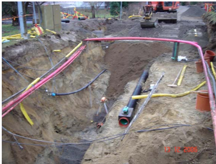
KUVA 11 Nummentien saneeraustyömaata talvelta 2006
