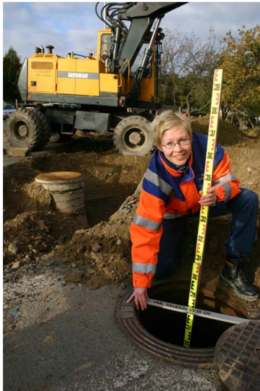
KUVA 10 Kaivon vesijuoksukoron tarkistusta Maijantiellä.
